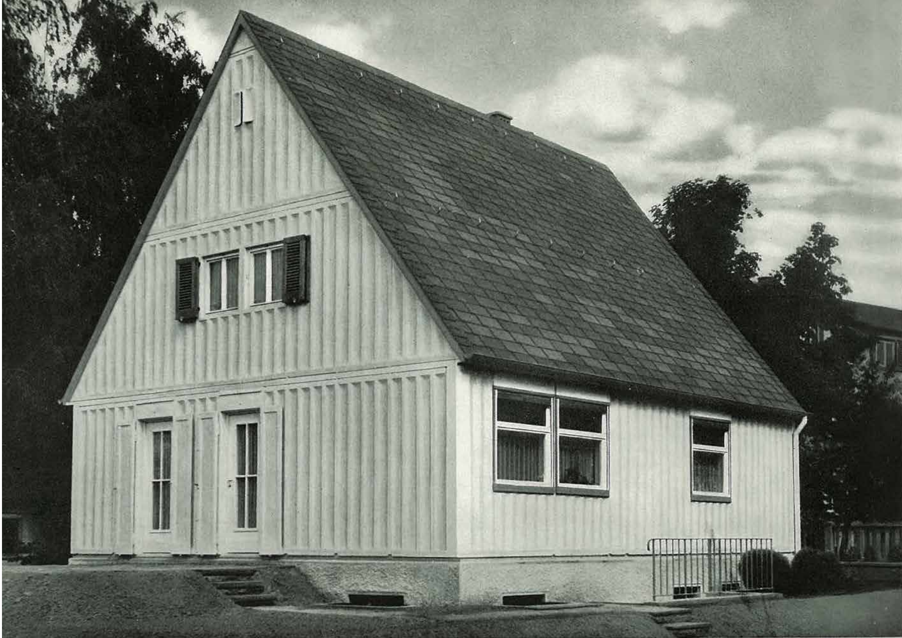
HAUS AN DER MAINSPITZE. Hier handelt es sich ebenfalls um ein 8×10-m-Steildachhaus mit oberem Stockwerk. Beim Bau dieses Hauses war die dem M·A·N-Haus eigene kurze Bauzeit besonders augenfällig. Der Bewohner flog am Tage des ersten Spatenstiches nach den USA, und als er nach genau acht Wochen zurückkehrte, konnte er in das fertige Haus einziehen.
