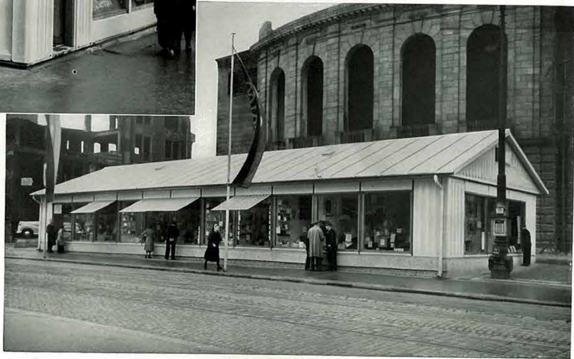
GESCHÄFTSHAUS IN MAINZ. (8×9 m) für ein Juwelier- und Schuhgeschäft. Das Haus wurde Ende Oktober in Auftrag gegeben und auf dem vorhandenen Trümmerfundament so rasch errichtet, daß Ende November das Weihnachtsgeschäft darin beginnen konnte.
